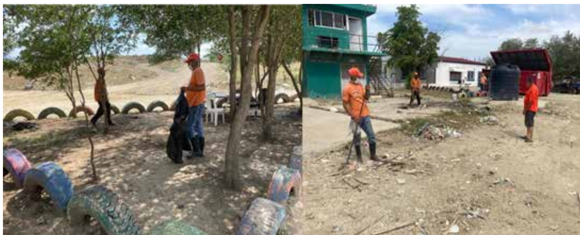
Fotografía donde se muestra los procesos de limpieza, adecuación y pintado de las edificaciones del Vertedero Rafey.
