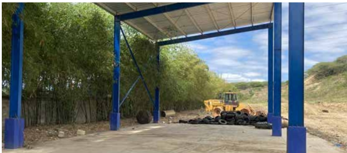
Proceso de construcción del taller de mantenimiento preventivo de los equipos pesados.
